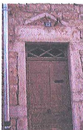
*l'arc de décharge au-dessus de l'encadrement est fonctionnel et doit être recouvert d'enduit*
