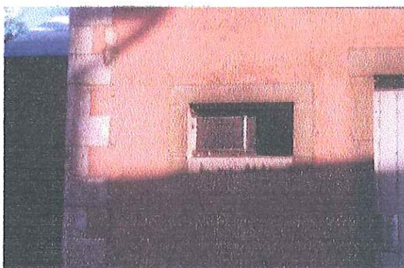
*Chaîne d'angle en trompe-l'oeil (badigeon) encadrement des ouvertures en pierres de taille taillées finement*
